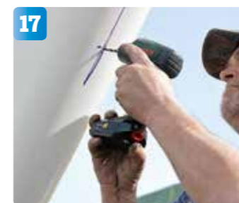
17 Ännu ett hål i plasten efter noggranna mätningar.
