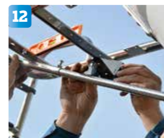
12 Staget ska monteras i 25 graders vinkel. Det känns dock inte som att det behöver vara mer exakt än att en vattenpass-app i en smartphone duger att mäta med.
