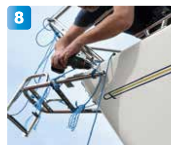
8 Sedan är det bara att borra och hoppas att mätningarna blivit rätt.
